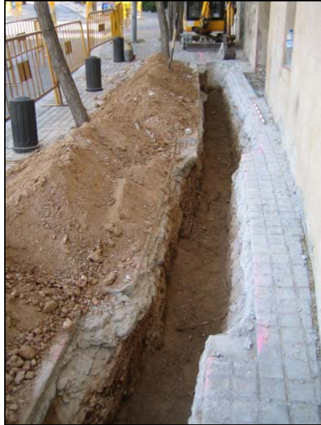
FOTO 5. Inici de la rasa 1
