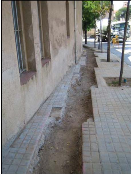
FOTO 9. Finalitzat el tram nord de la rasa 1
