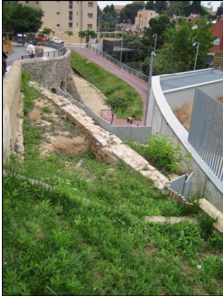
FOTO 13. Mur documentat al carrer Bellesguard núm. 19-23
