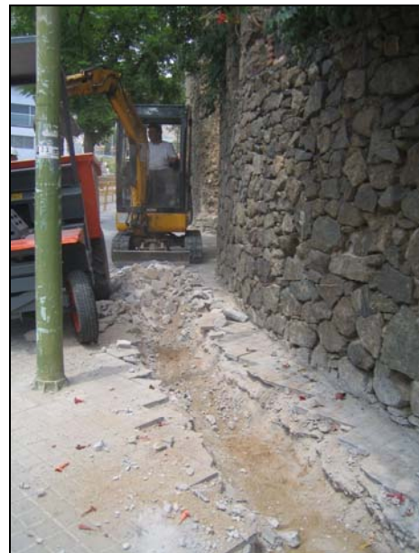
FOTO 4. Inici de la rasa 1
