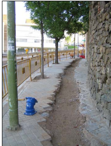
FOTO 8. Finalitzat el tram sud de la rasa 1
