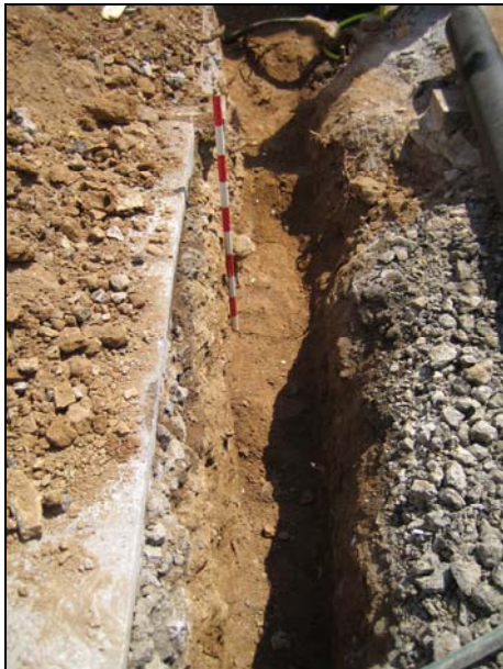
FOTO 11. Rasa 2. Situació del tram de mur UE 9
